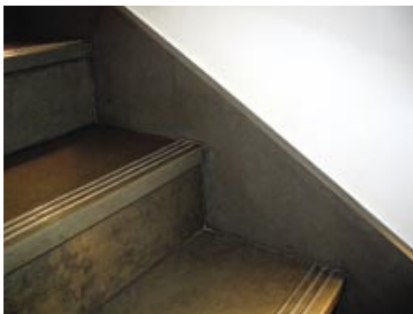
Fot. 17.8 Wangi schodowe.
