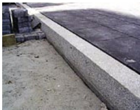
Fot. 17.4 Krawężniki przygotowane do montażu i zmontowane.
