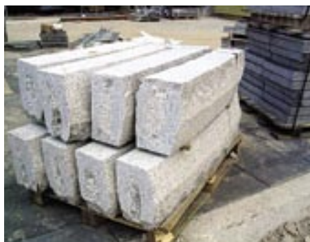
Fot. 17.4 Krawężniki przygotowane do montażu i zmontowane.
