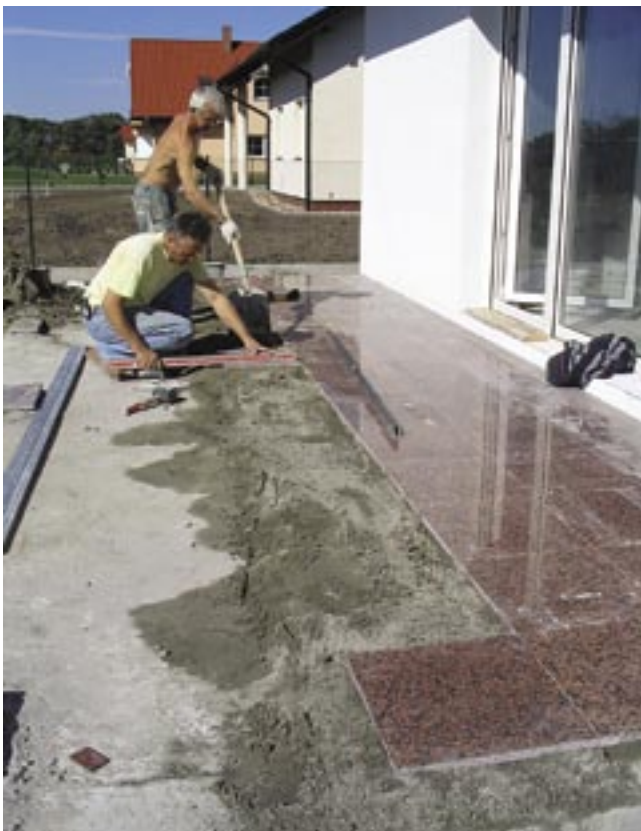
Fot. 17.3 Montaż posadzki zewnętrznej.
