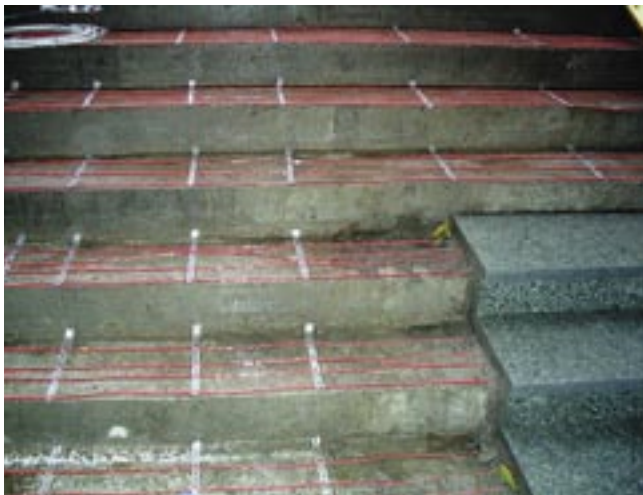
Fot. 17.10 Montaż ogrzewania elektrycznego pod kamieniem.
