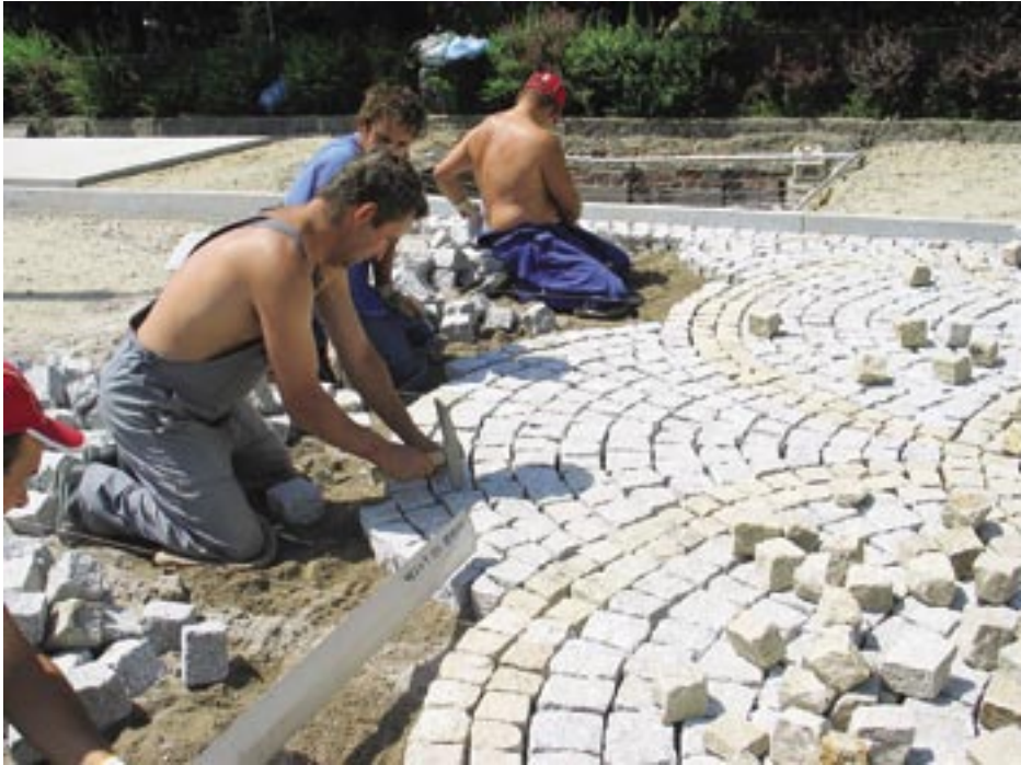
Fot. 17.6 Układanie kostki granitowej.
