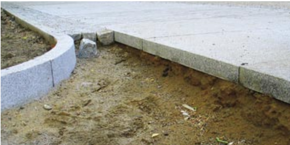
Fot. 17.2 Montaż płyt chodnikowych.
